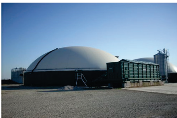
Figura 4 Impianto di digestione anaerobica
